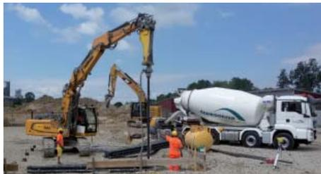
Um die Standfestigkeit des Fundamentes zu garantieren, ist das Schlagen von Piloten erforderlich.
